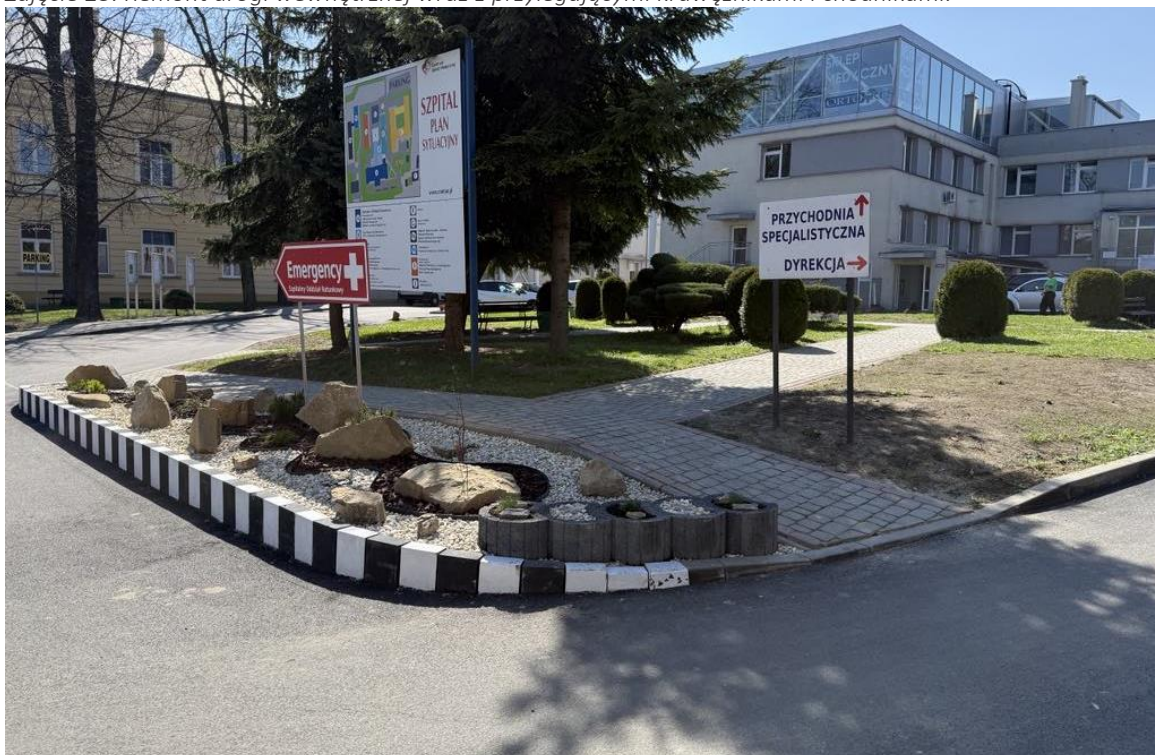
Zdjęcie 25. Remont drogi wewnętrznej wraz z przylegającymi krawężnikami i chodnikami.
