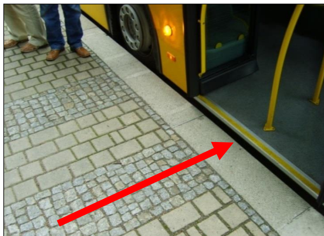
Rys. 8.6.2. Strefa wejściowa – inny rodzaj nawierzchni naprzeciwko pierwszych drzwi autobusu. Źródło: TRAKO.
