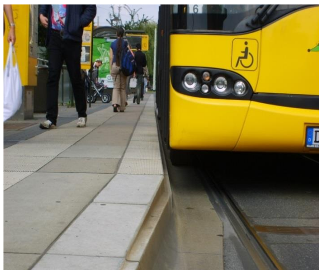
Rys. 8.6.1. Zalecane ukształtowanie krawędzi peronowej. Źródło: TRAKO.
